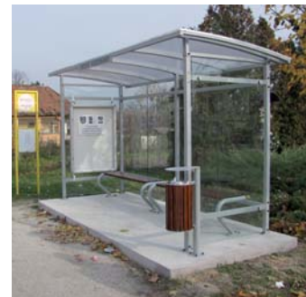
Oprava autobusovej zastávky v obci Veľké Vozokany (Obec Veľké Vozokany)
