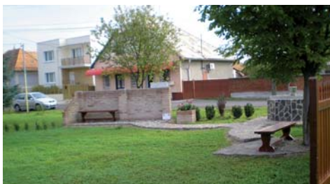
Rekonštrukcia a modernizácia drobnej architektúry „Na priedomí“ (Obec Čajkov)
