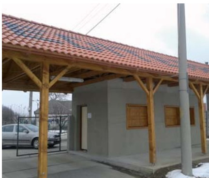
Výstavba prístrešku (Obec Neded)
