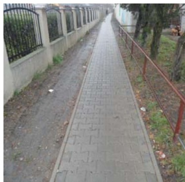
Rekonštrukcia chodníka v obci Tešedíkovo (Obec Tešedíkovo)
