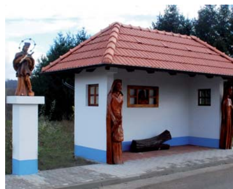
Netradičná autobusová zastávka s využitím prvkov ľudovej architektúry (Obec Radava)
